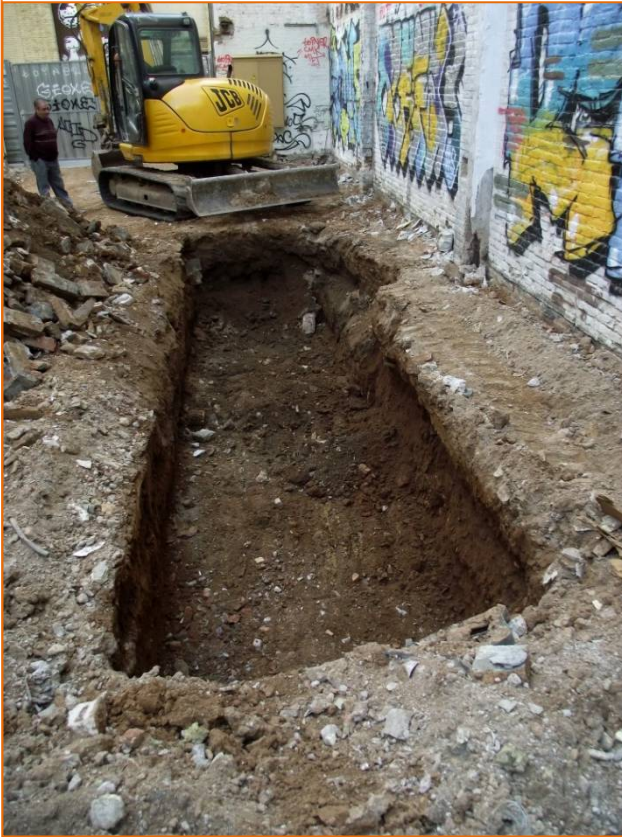
Foto 5. Fossat de cotxes 2 desmuntat.
