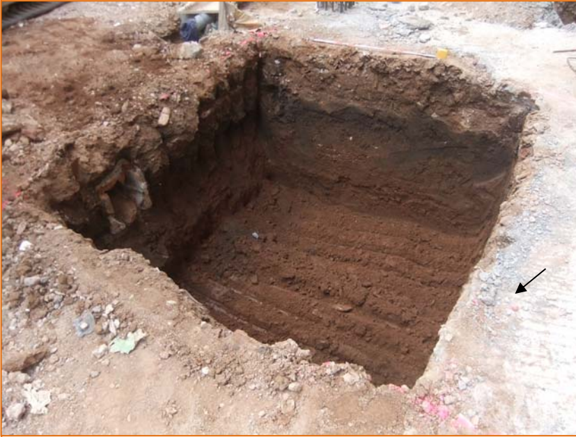
Foto 17. Vista del fossat d'ascensor.
