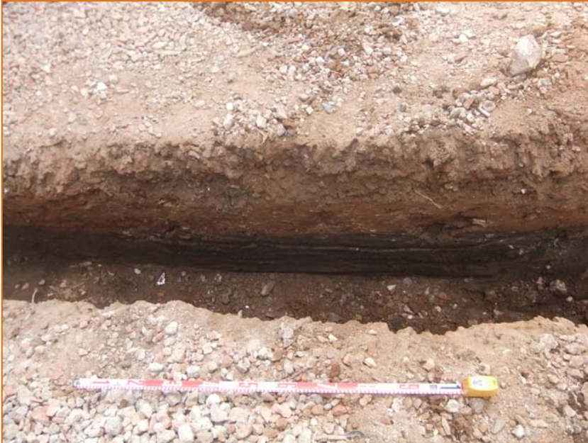
Foto 13. Vista de la riostra 7.
