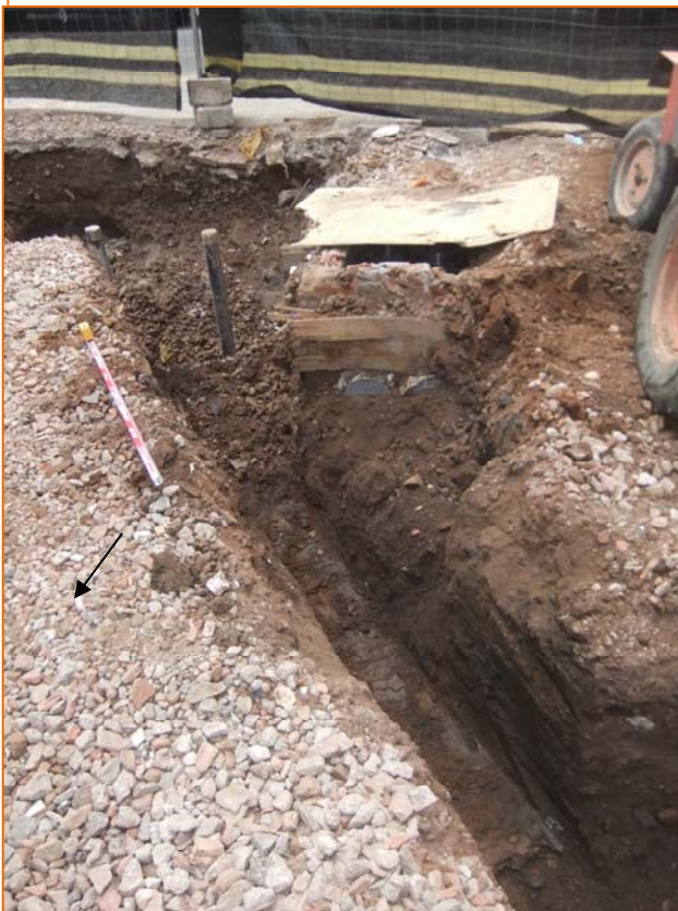
Foto 14. Vista de la riostra 8.
